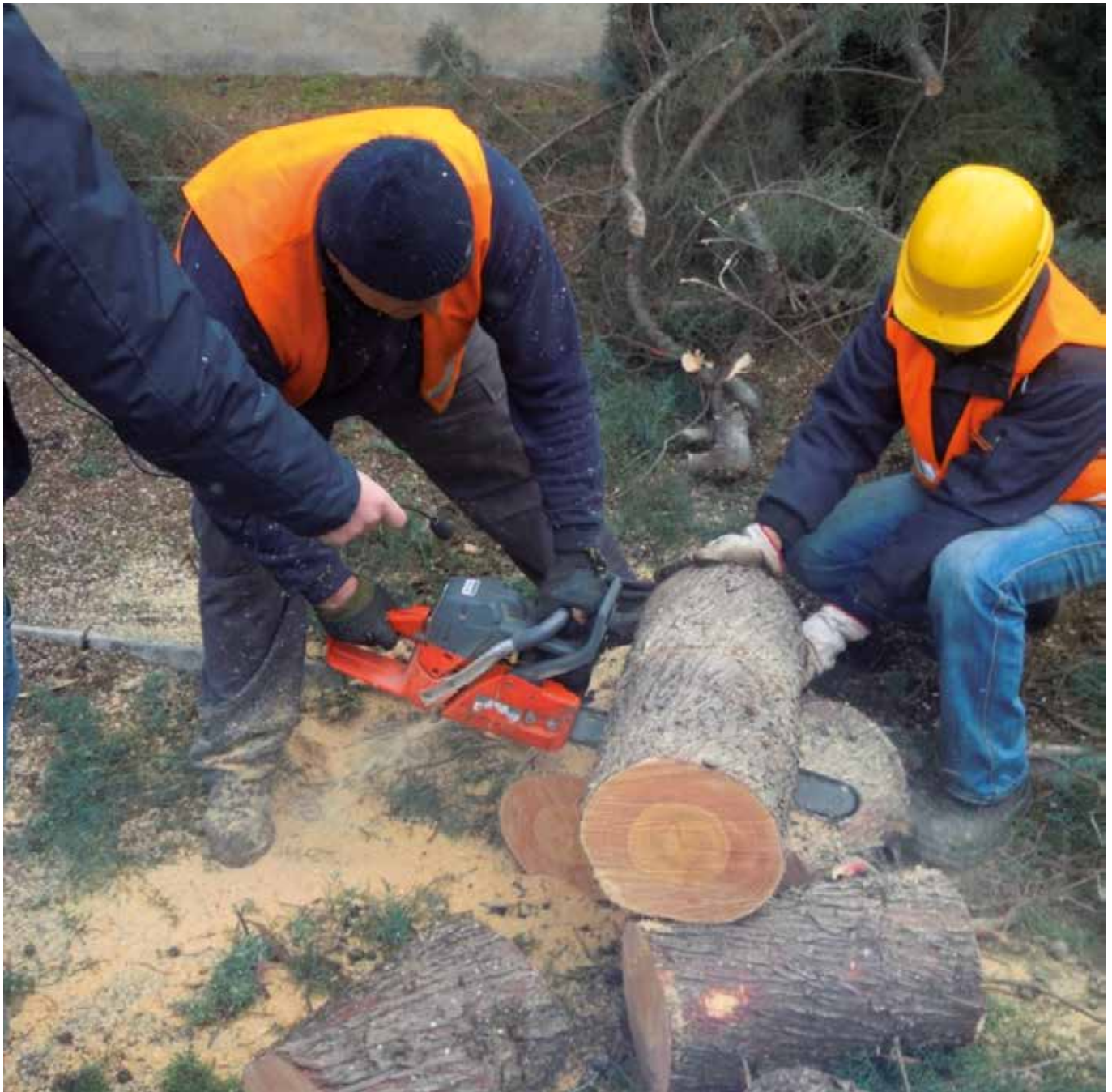
▲ Operazioni di allestimento in cantiere gestione del verde urbano.
